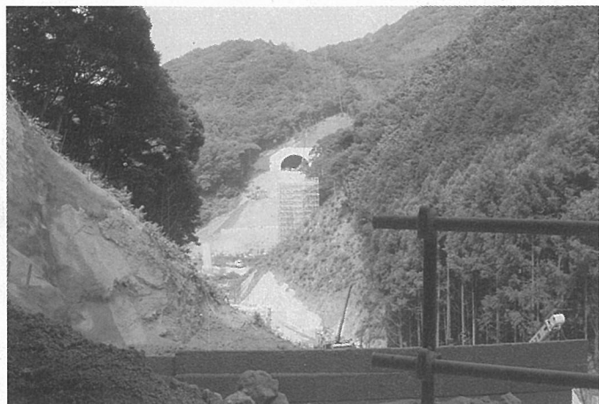
整備中の萩三隅道路
