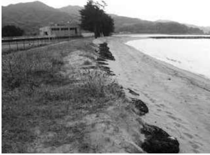
施工前（令和8年3月31日）
