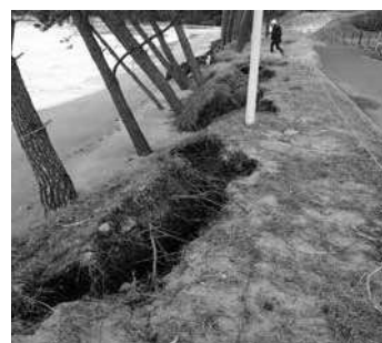
波浪により、松の木が倒木している状況(令和4年12月撮影)
