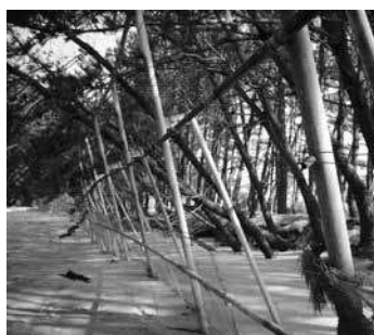
暴風ネットが倒れそうになっている状況(平成18年1月撮影)
