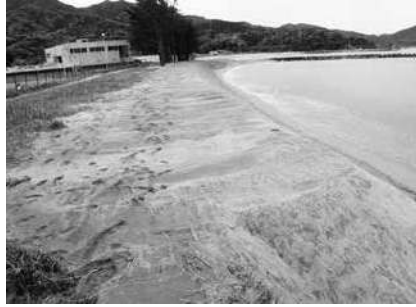
施工後（令和8年4月24日）
