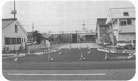
田町商店街駐車場工事風景
