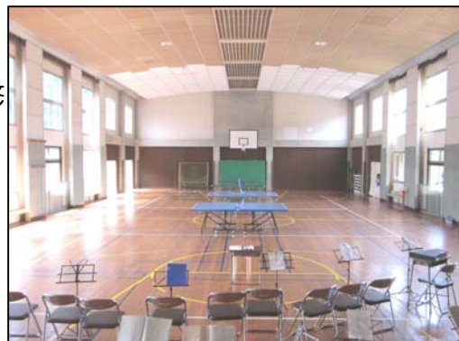
明木中学校屋内運動場▲
