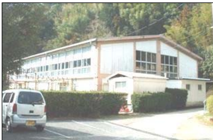
白水小学校屋内運動場▲
