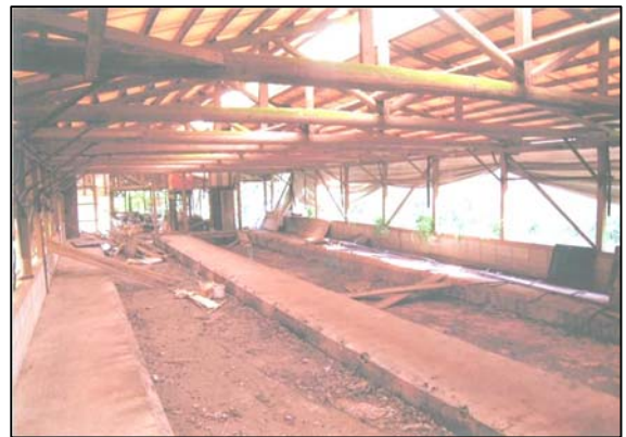
牛舎改築予定の養豚舎▲
