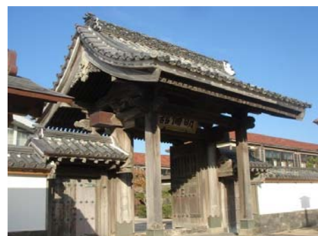
66. 明倫館遺構 南門
