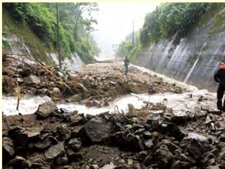
金山谷トンネル (28日)
