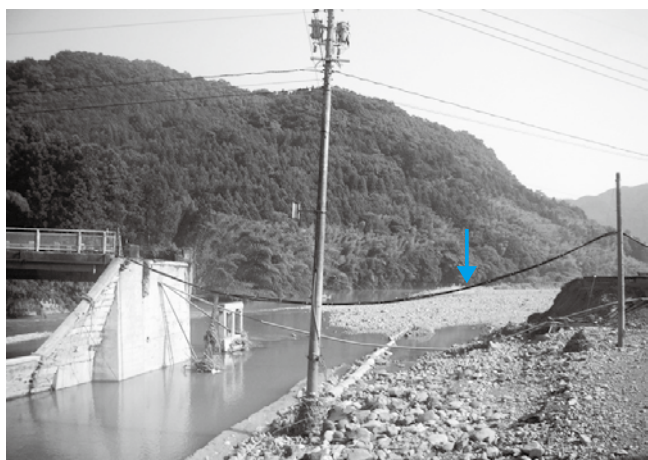
小川配水管(高岩橋)
