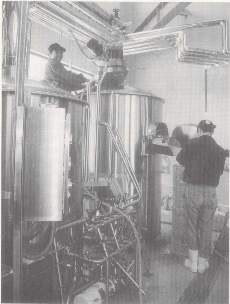
山口萩ビールのタンク
