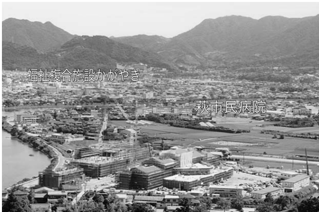
建設中の萩市民病院（萩・健康維新の里）
