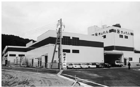
県漁連の製氷・冷凍冷蔵工場
