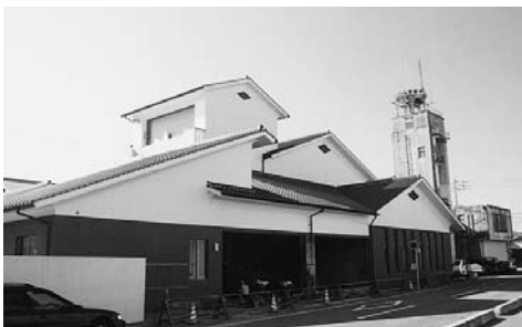
新築工事中の消防署庁舎
