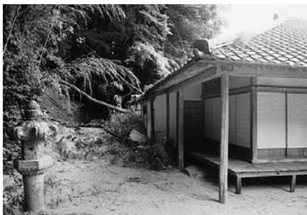
土砂で書院の一部が壊れ、庭園も埋まった 萩市指定文化財 大照院書院
