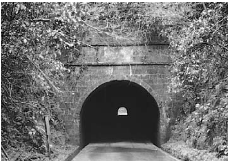
国登録文化財に指定された鹿背隧道
