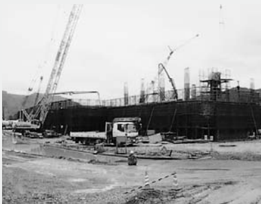
椿門田地区の建設現場
