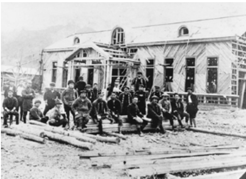
建築途中の萩駅舎 (椿、大正13年頃)
