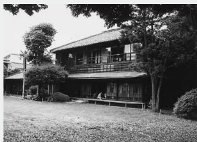
解体前の伊藤博文別邸（東京都）
