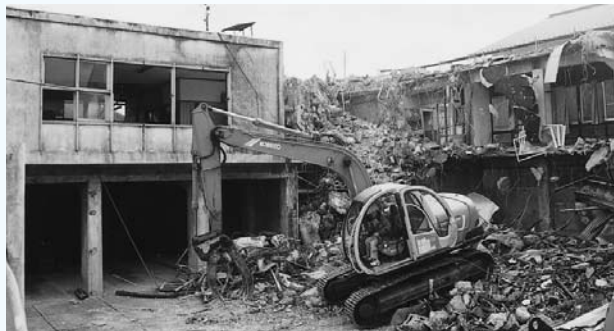
旧消防庁舎の解体の様子
