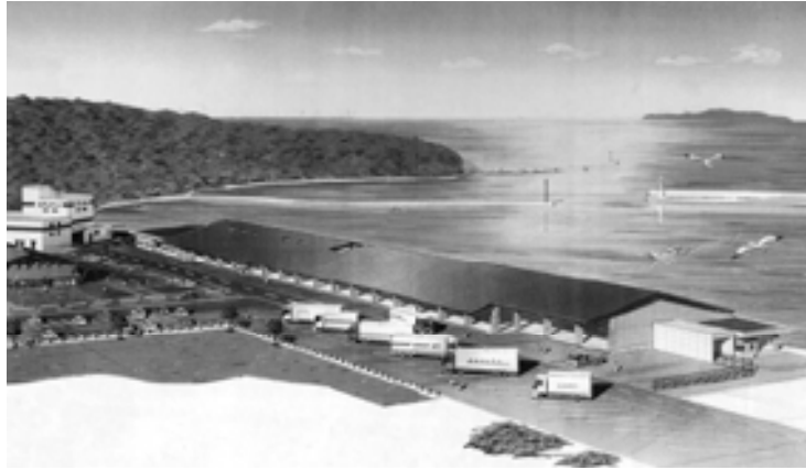
水産物卸売市場の完成図（画面左上が冷凍冷蔵工場、下が萩しーまーと）
