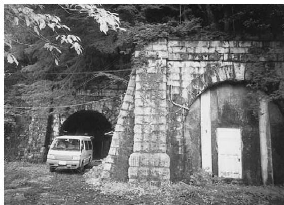
▲今も残る逢坂山トンネルの遺構 (大津市逢坂1丁目)
