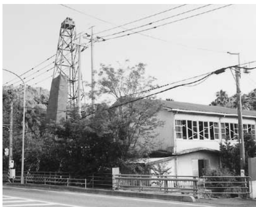
温泉掘削時に、中学校体育館横に建てられた高さ25mの矢倉
