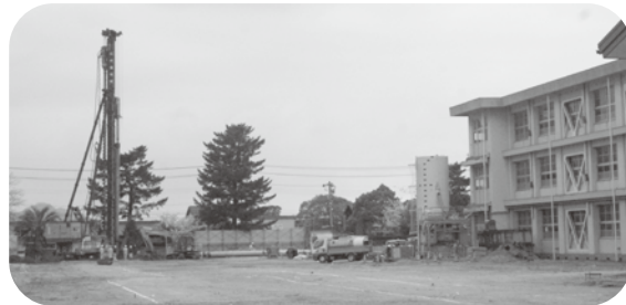
建設中の明倫小学校
