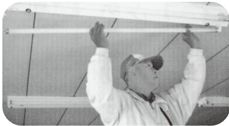
蛍光灯の取り換え作業
