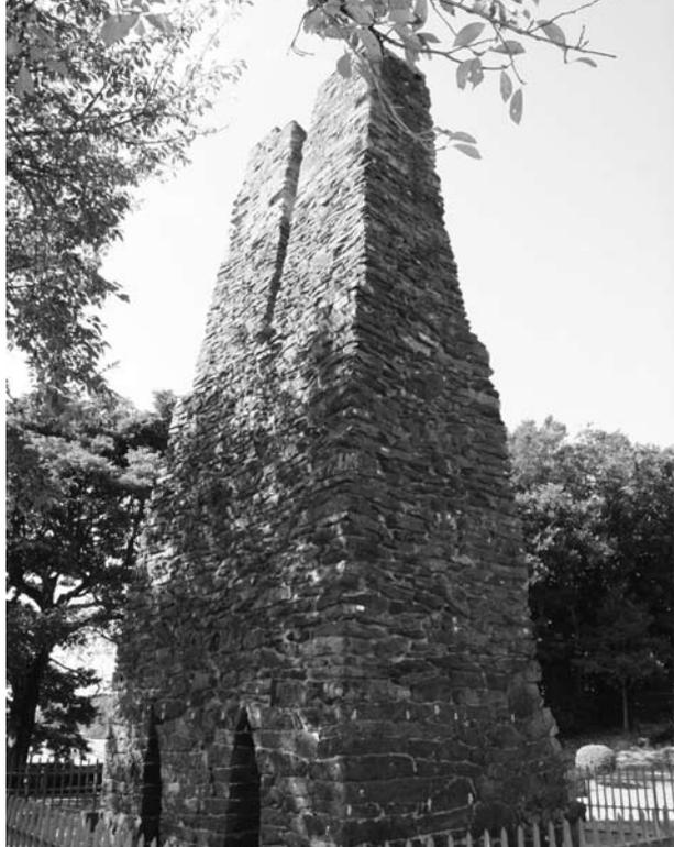
△萩反射炉(前小畑) 欧米列強の圧力に危機感を持った萩藩が、鉄製大砲の鑄造を目指して自力の試行を行ったことを示す反射炉(試験炉)。
