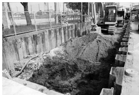
写真1: 雑賀下がり筋(明倫小東側)の道路側溝工事
