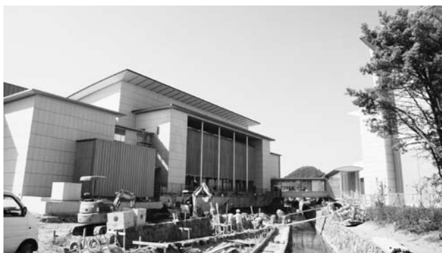
建設中の陶芸館。藍場川を挟んだ本館(右側)とは渡り廊下で往来できます
