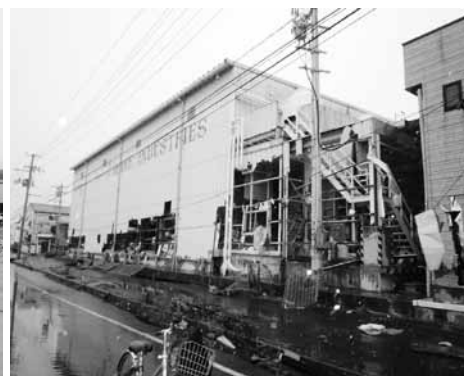
壊滅的な被害を受けた石巻市魚町の社屋
