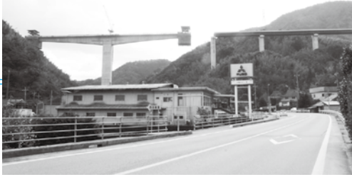
高架橋の工事が進んでいます(山田,2月)
