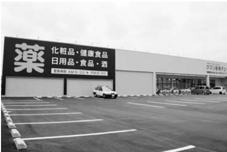
くすりの岩崎（土原）外壁をピンク 色のシンボルカラーから、市内の ガードレールにも使われているダーク ブラウンに
