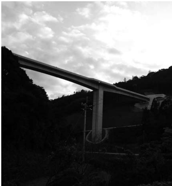
△現在建設中の萩・三隅道路 (7つのトンネルと5つの橋りょう)
