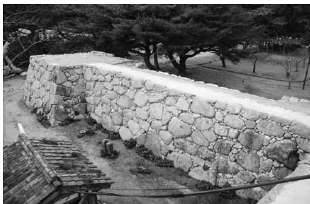
南東側から見た萩城跡本丸門跡の石垣
