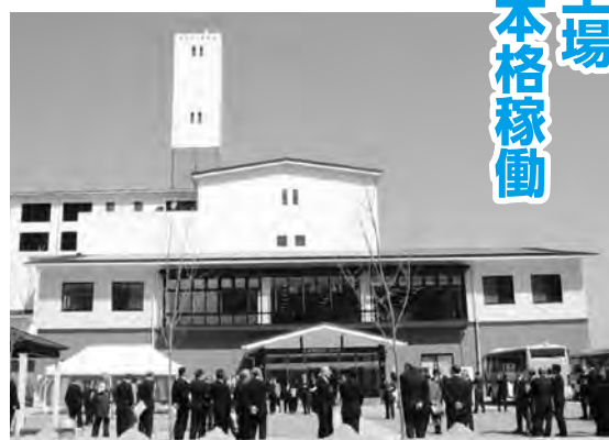
萩・長門清掃工場(3月25日、竣工式)
