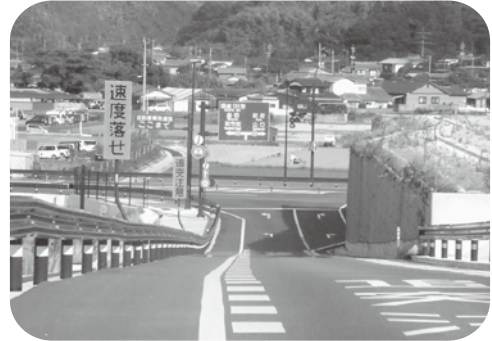
山陰自動車道萩インター
