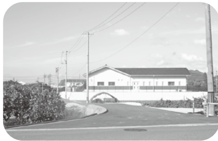
樫南浄化センター
