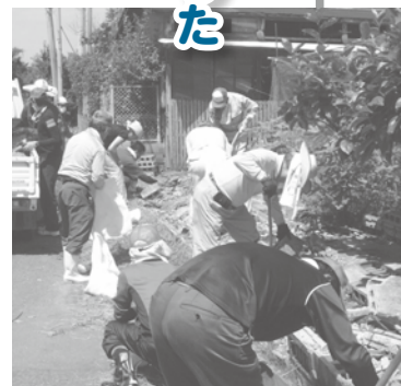
崩れたブロック塀を片付けるボランティアの皆さん
