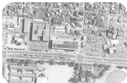
空から見た萩市役所
