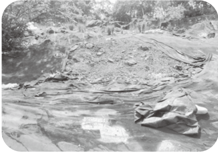
土砂災害現場
