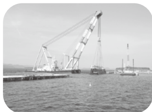
大島漁港特定漁港漁場整備工事
