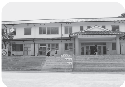
明木小・旭中学校新築校舎
