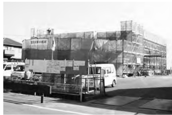
工事が進む女子寮（12月上旬）
