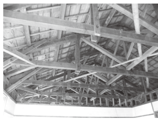
小屋組の状況
