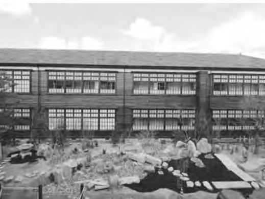
中庭(本館と2号館、東側)
