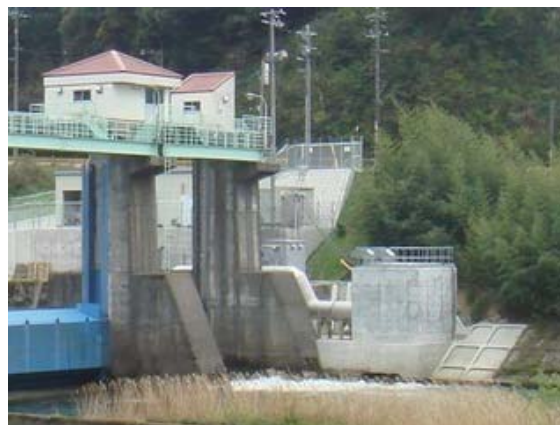
■相原発電所 出典) 山口県
