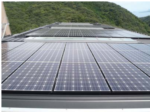
■萩・長門清掃工場「はなもゆ」屋上
