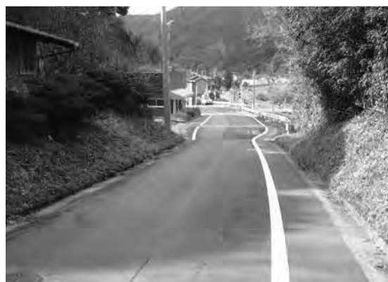
市道大浴線の歩行者帯整備
