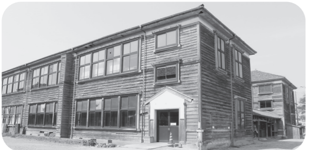
整備前の萩・明倫学舎3・4号館
