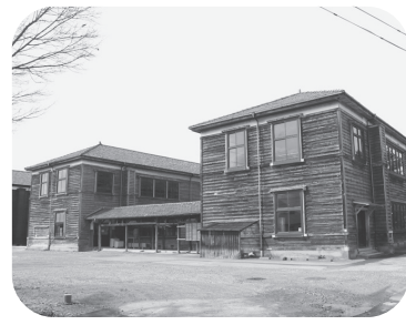
萩・明倫学舎3・4号館
