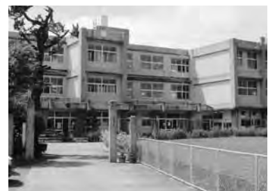
改修される旧大井小学校
