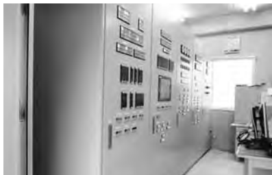
◀見島浄水場の監視機器
