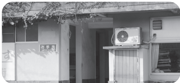
新堀駐車場のトイレ
