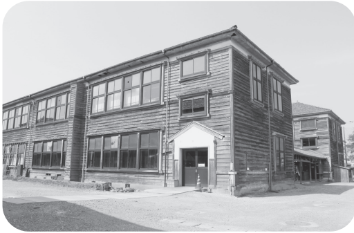
旧明倫小学校3・4号棟
