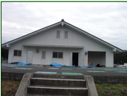
下田万地区集落排水浄化センターの建屋
