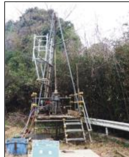
ボーリング仮設例
