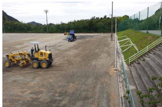
整地工事(須佐グラウンド) H26.5月
