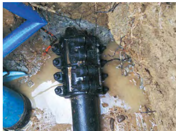
漏水補修完了状況
