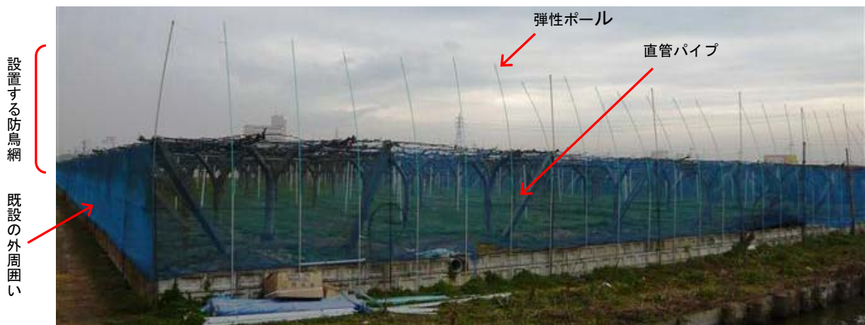
写真3 直管パイプを地中に打ち込んで、その中に弾性ポールを差し込む、より安定度が高い方法。
