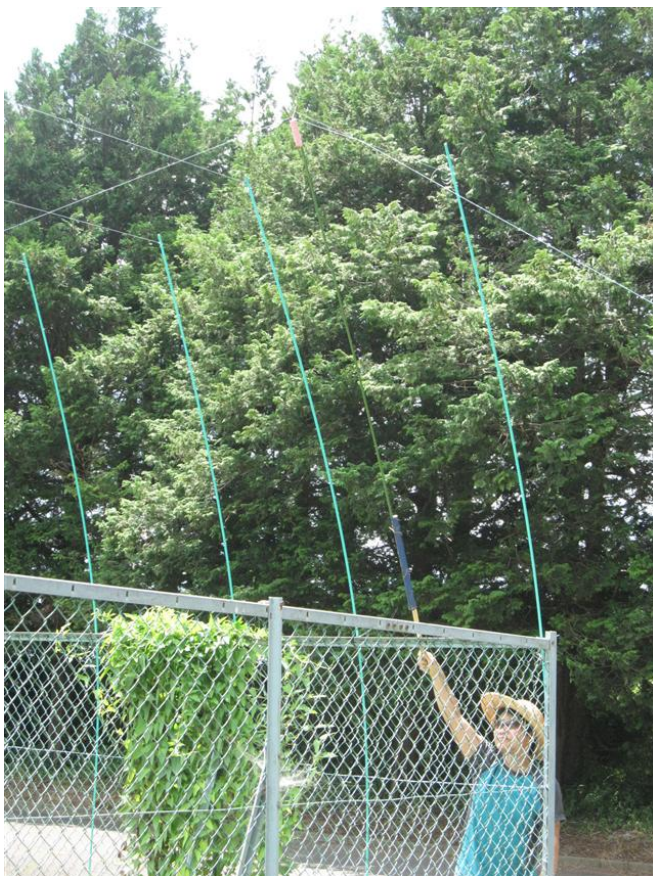
写真6 手製のY字竿を使い、新しいテグスを既に張ったテグスの上に載せる
