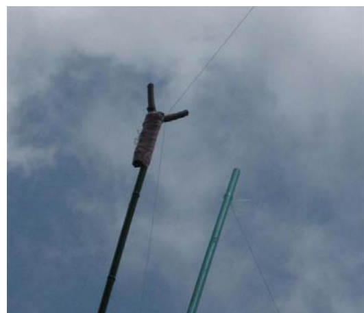
写真8 Y字竿を使ってテグスを支えて弾性ポールを越えさせる
