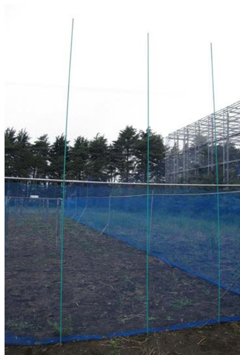
写真2 弾性ポールを地面に数cm 刺し、果樹園の外周枠に結束バンド で固定する
