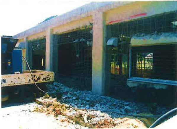
屋根・外壁の解体から工事スタート
