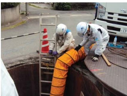
マンホール工
