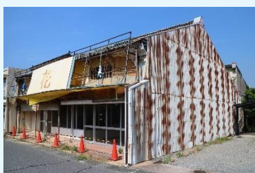
改修前の伝統的建造物
