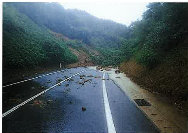
平田（へいだ）トンネル付近の土砂崩れ
