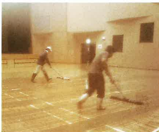
文化センターの泥出し作業
