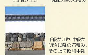
下段が江戸、中段が明治以降の石積み、その上に昭和中期の土堀と屋根
