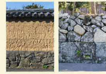
笠山石の基礎を用いた本瓦葺き土堀
