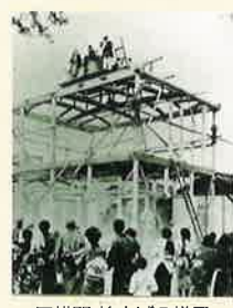
五松閣 棟上げの様子
