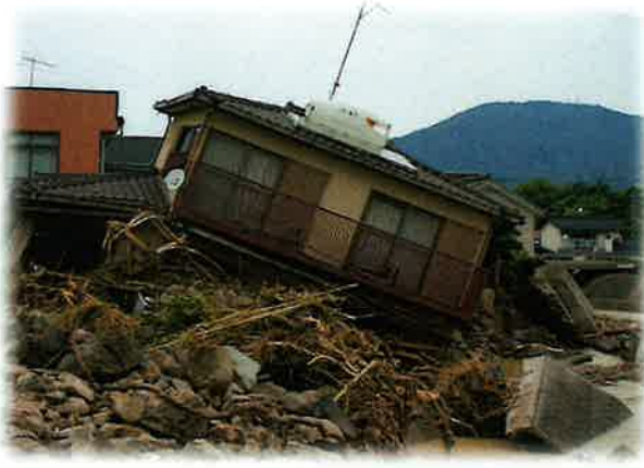
平成 25 年 7 月 28 日山口県北部豪雨災害
