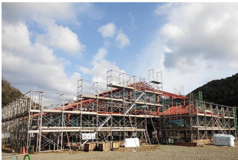
建設現場の様子
